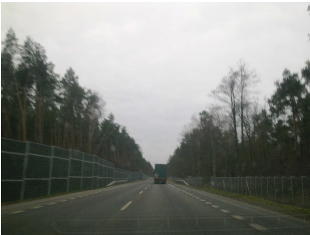
Fot.1 widok na fragment obszaru – pas terenu przyległy /po prawej stronie/ do drogi wojewódzkiej – obwodnicy Mielca, po lewej widoczny ekran akustyczny ograniczający MKG OChK
